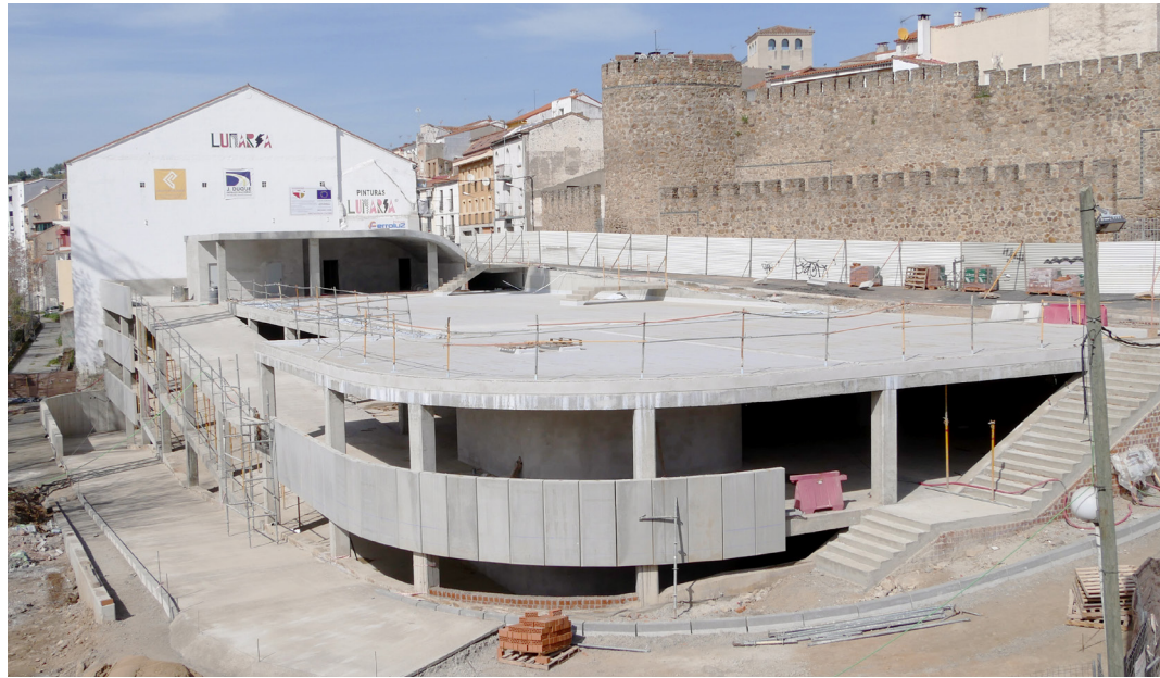
El aparcamiento Rosario Cordero se encuentra situado a los pies de la muralla y próximo al puente Trujillo. Se prevé su finalización y puesta en marcha durante este mes de abril.
